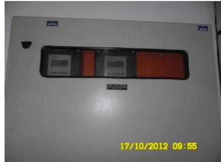
Medidores de vazão nas duas adutoras de água tratada
