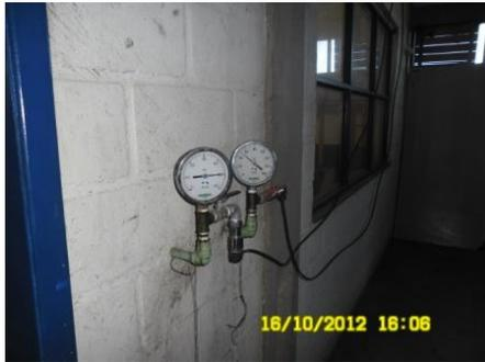
Manômetros na tubulação de sucção e recalque
