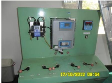
Medidores on-line da água tratada dos parâmetros turbidez, cloro e pH
