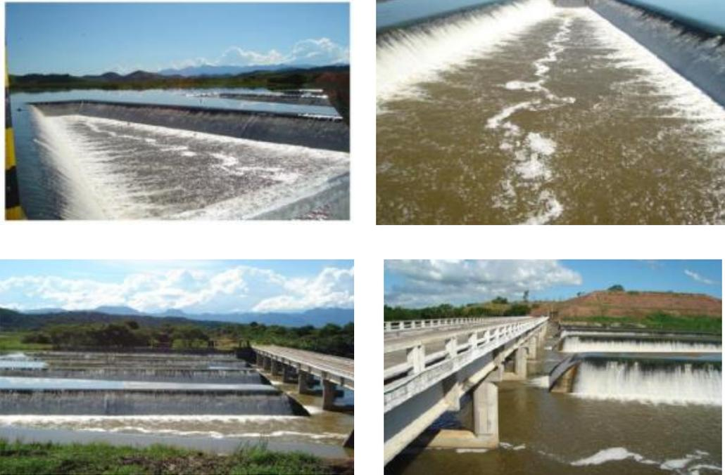
**Figura 8 - Vertedor Represa de Juturnaíba**
