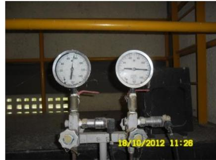
Medidores de pressão nas tubulações de sucção e recalque
