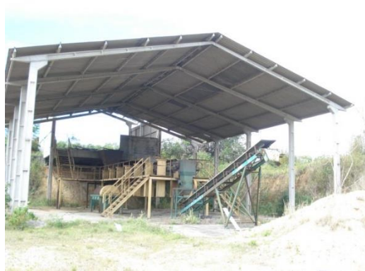
Galpão de Triagem
