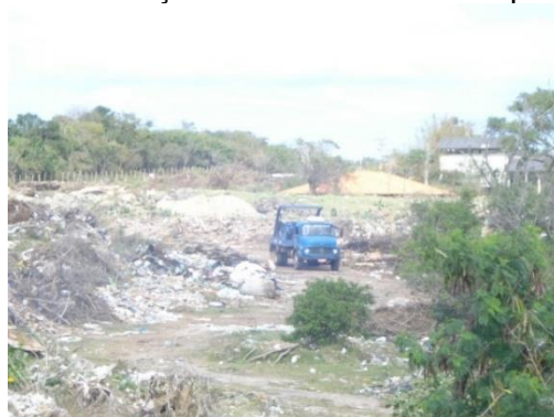
Descarregamento de RCC
