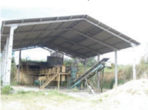
Galpão de Triagem
