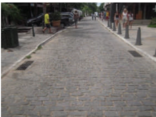
Coleta de águas pluviais/conjunto de bocas-de-lobo
