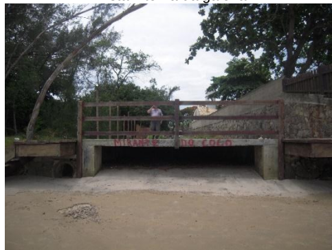
Obra do INEA para descarga de águas pluviais (2 tubos de 1m) + galeria em concreto
