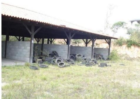
Baias com armazenamento temporário de pneus
