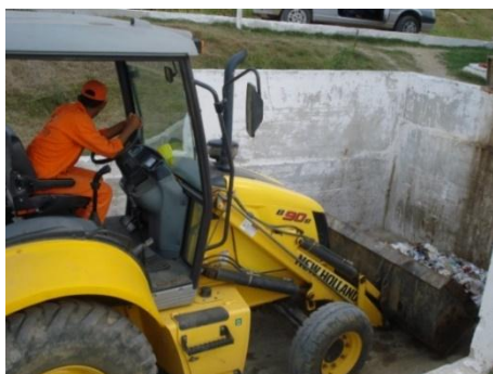
Fosso de descarga
