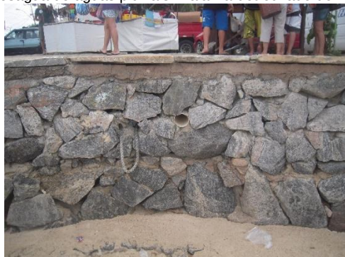
Local com drenagem interceptada, ao lado do pier.
