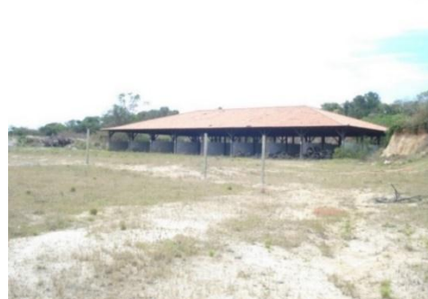
Galpão das baias
